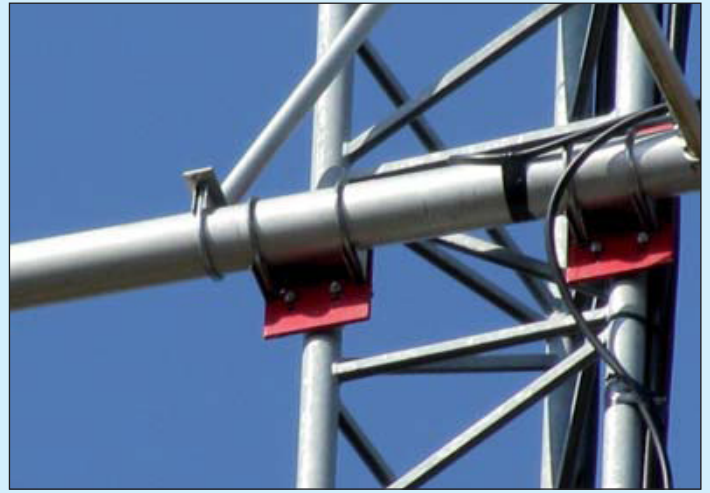
Kuva 9. Laipat ristikkoon kiinnitystä varten.
