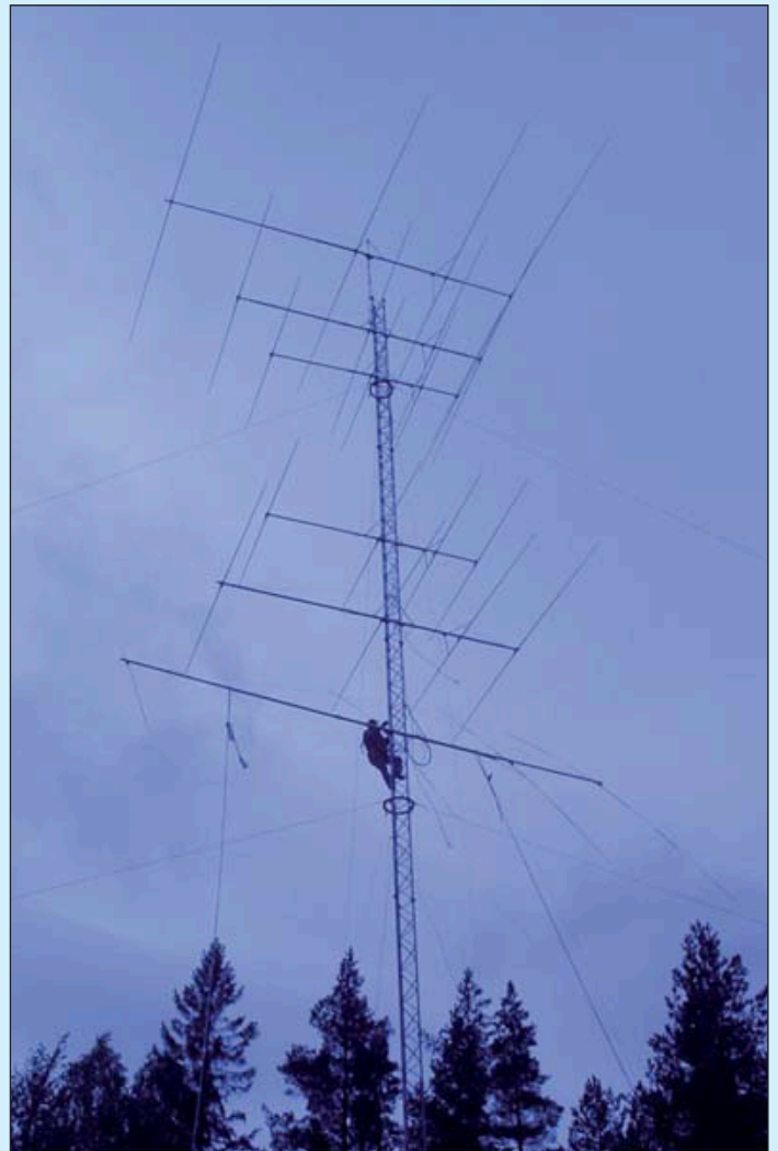
Kuva 10. Kirjoittajan 4-el. stakki 20-10 m, mastossa OH4MS asentamassa viimeistä yägiä.
